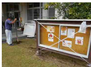
撤去作業のようす
