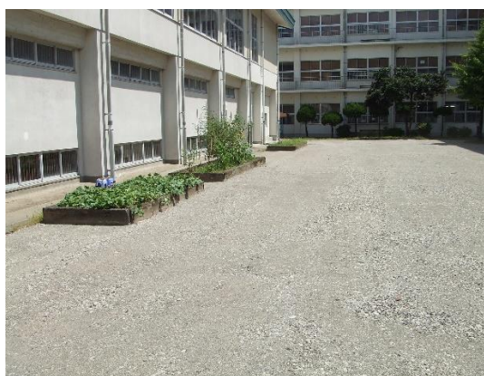
＜体育館横の砂利入れ・整地＞
