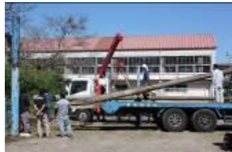
【支柱の運搬の様子】
