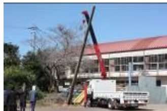
【支柱建ての様子】
