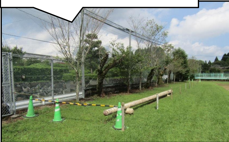
運動場北側（プール側）の工事区域
