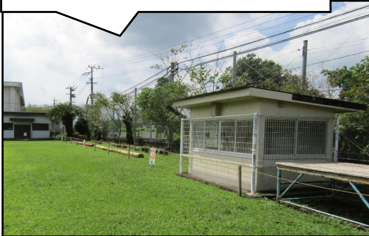
運動場北側（校舎側）の工事区域
