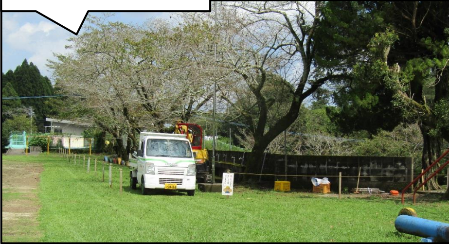
運動場南側の工事区域
