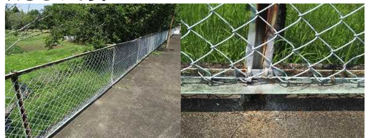
【プロ顔負けの技で修繕されたフェンス】
