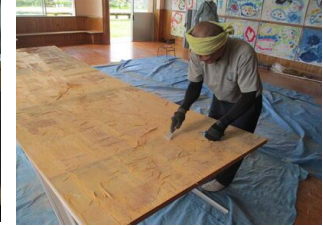
【黒板の張り替え】
