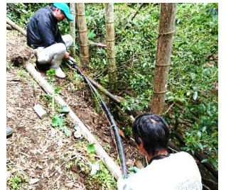
【匠の技で修理完了】
