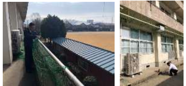
20mのネットをベランダからたらし地面に固定しています
