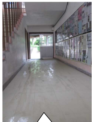
体育館へ向かう廊下
