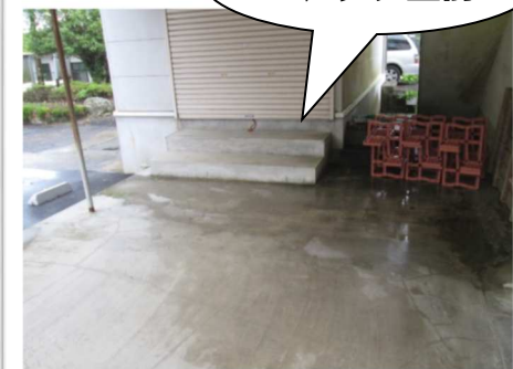
コンテナ室前
