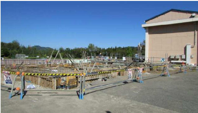
【校門入口付近 幼稚部校舎建設現場】
