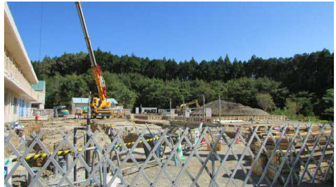
【南校舎南側 前期ブロック校舎建設現場】
