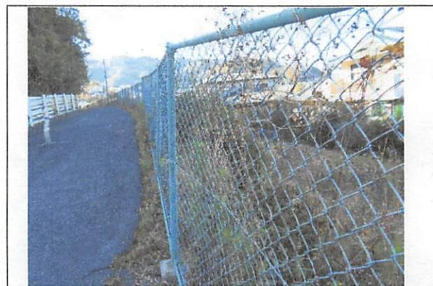
フェンスが傾いており、台風や竜巻などが発生したときに倒壊し、飛んでいく危険性があり、倒壊後、フェンスがなくなり、坂になっている草むらに転げ落ちる危険性もあるので、災害が起った場合は、近づかない方が良い。
