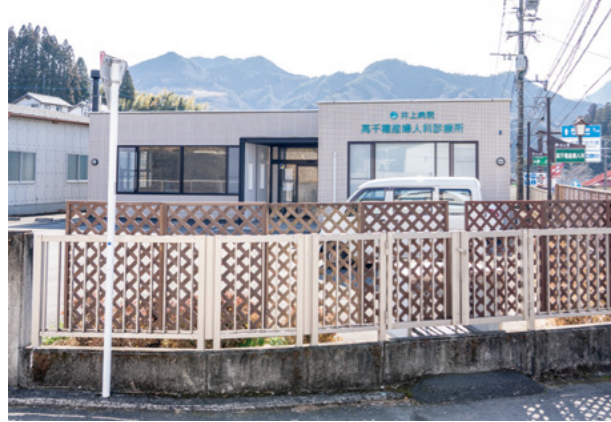
▲外観。駐車場には目隠しがあります。
