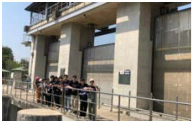
日本の ODA で建設されたパサック川水門でのフィールドワーク
