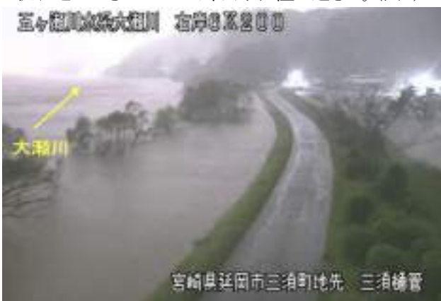
図4 令和4年の台風14号の内水氾濫(三須町)
