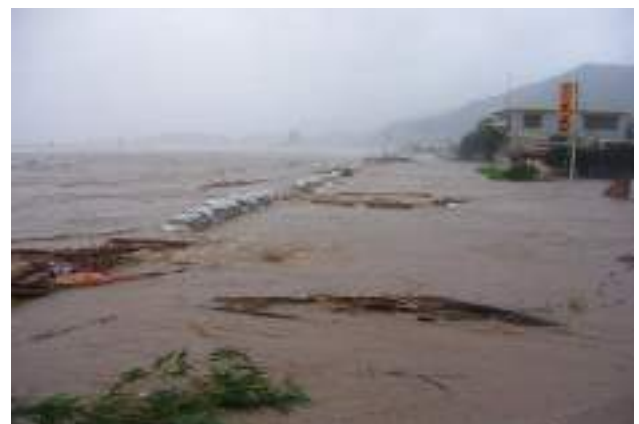
図2 平成17年の台風14号による越水(岡富町)
