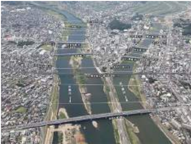
図3 隔流堤 2つの河川(五ヶ瀬川と大瀬川)が合流するところに堤防を築堤し、河川の流れがスムーズになるようにしたもの。
