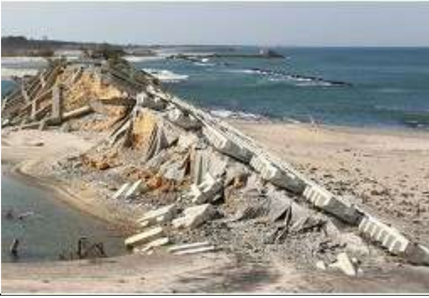
東日本大震災による海岸堤防の被災状況↓
