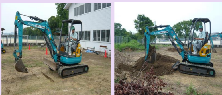
小型車両系建設機械掘削の様子
