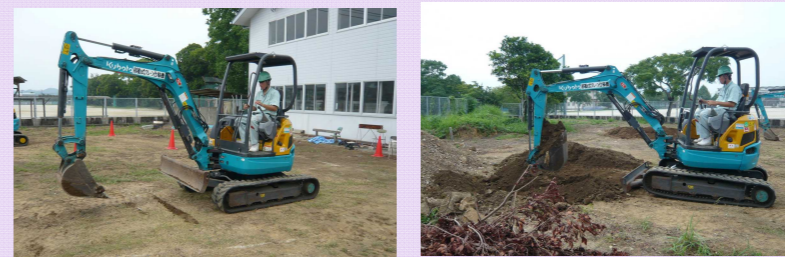
小型車両系建設機械掘削の様子
