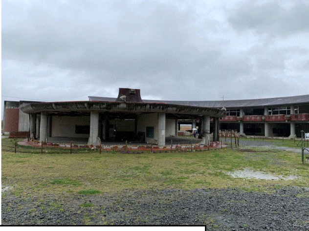
津波で壁がなくなった大川小学校
