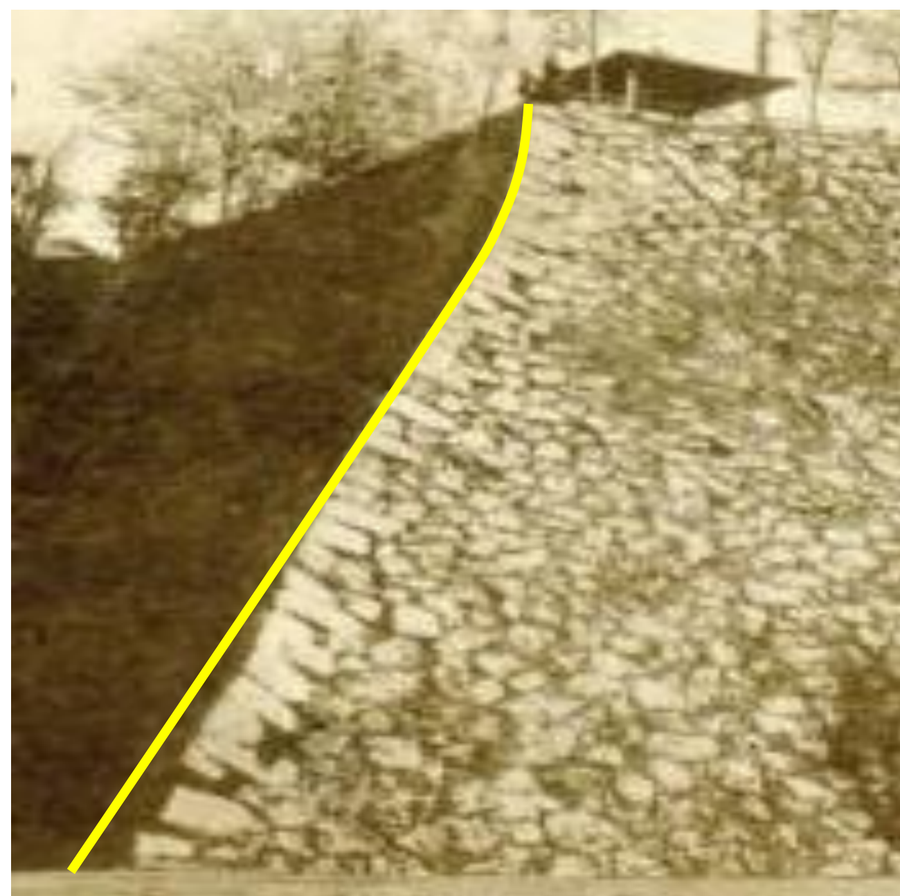
図II 隅石の残る写真の発見 大正時代の石垣の写真。隅石の部分が少し出ているのが分かる。また、角の稜線が下の方に向かって右側に曲がっているのが分かる。(馬場和久「絵葉書でたどるのべおか温故知新」からの引用)
