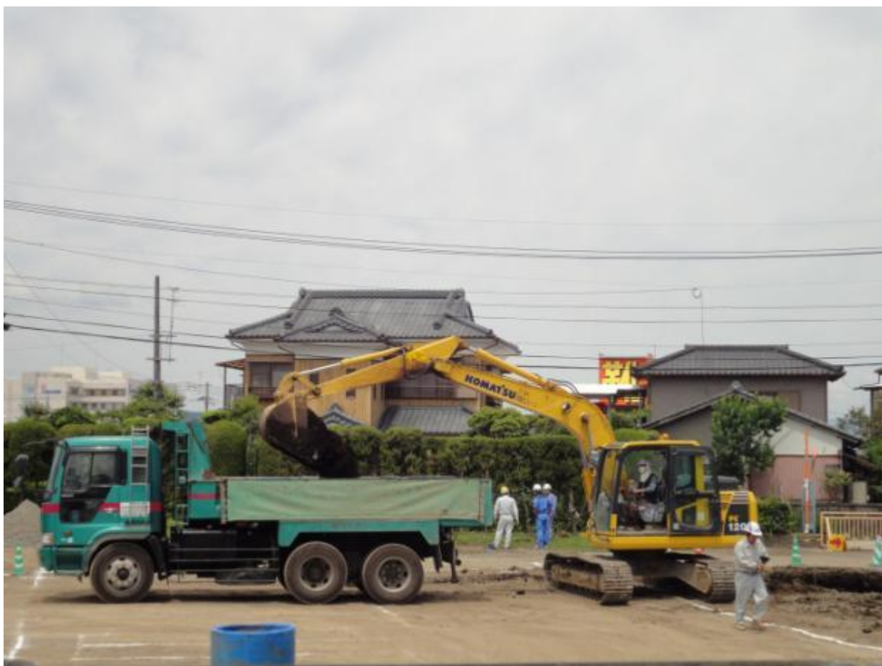
ショベルカーで掘った土は、そのまますぐにトラックに積んで、高原町まで運び出されます。
