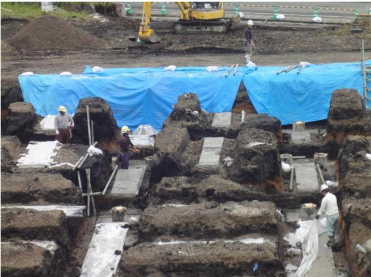
流し込まれた生コンにビニールがかけられ、雨に濡れて劣化しないようにしてあるようです。また、穴が崩れないようにブルーのシートも設置してあります。梅雨の時期は作業員の方も大変です。
