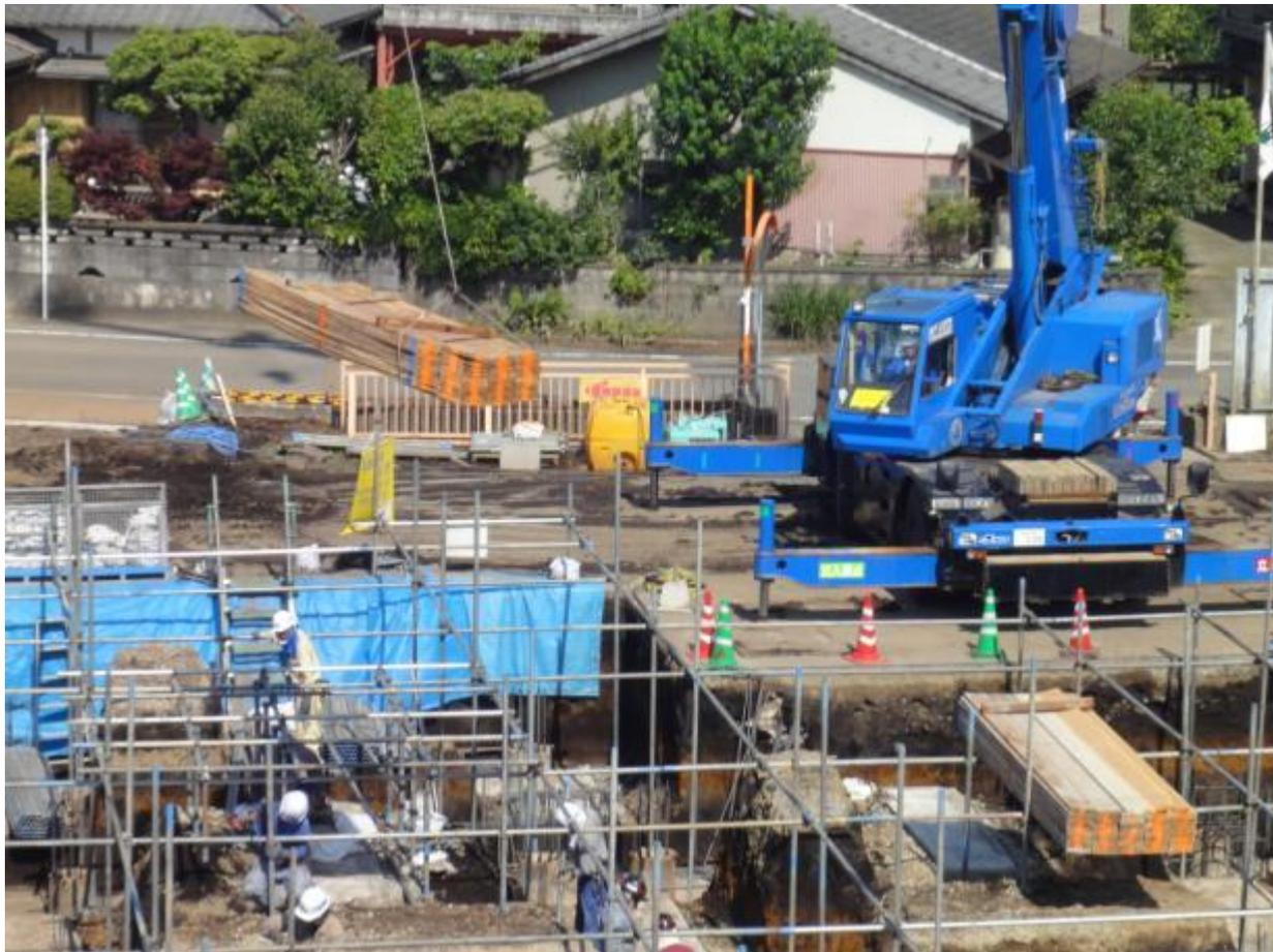
クレーンで資材が移動している下では、鉄筋の設置などが進んでいます。安全管理が重要です。
