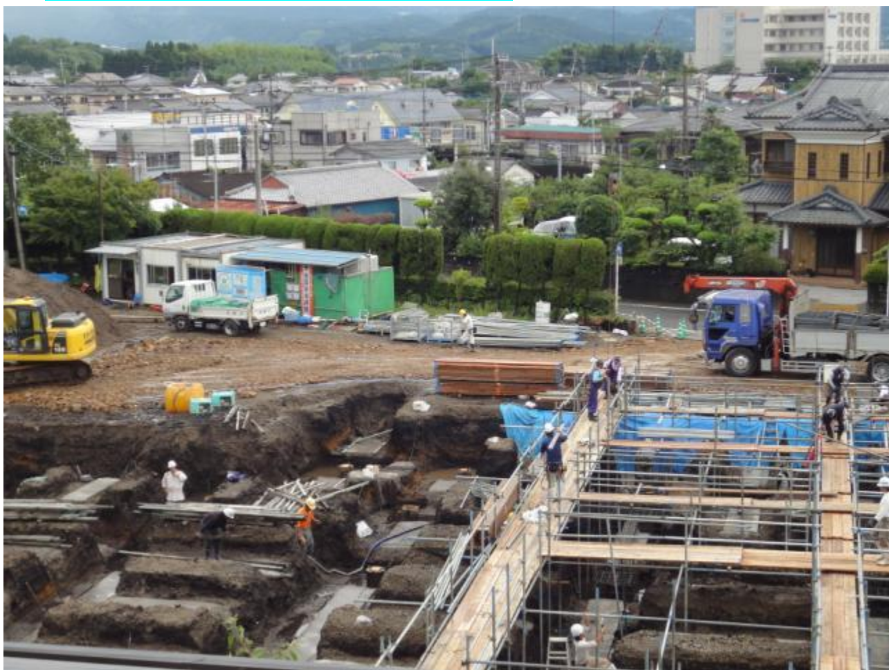
足場作りが急ピッチで進みました。足場の板の上を作業員の方たちが、資材を肩に担ぎながら歩きます。
