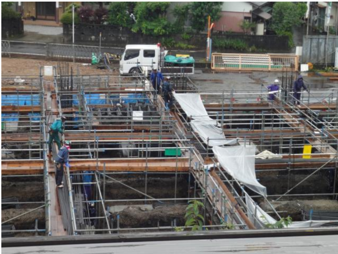
雨の日も作業は進んでいます。足場に掛けられたビニールシートの下では鉄筋を溶接で設置しています。
