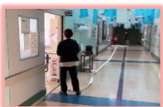
初期消火(消火栓)
