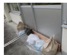
↑ 作業の様子 → 設置した防水板や土嚢など
