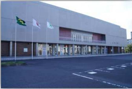
宮崎県体育館
